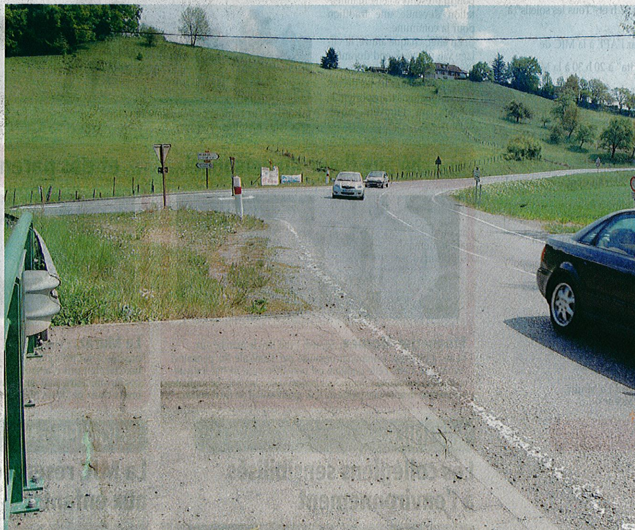
C'est à cet endroit qu'un rond-point va prochainement sortir de terre après deux mois de travaux. Et des perturbations...
