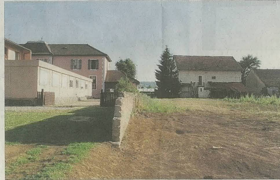
1 000 m 2 de terrain ont été achetés pour la construction de l'école maternelle sur une surface bâtiment de 83 m 2 .
